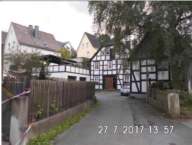
Abbildung 6: Eingetragenes Denkmal „Fachwerkhaus Überhenne 14“
